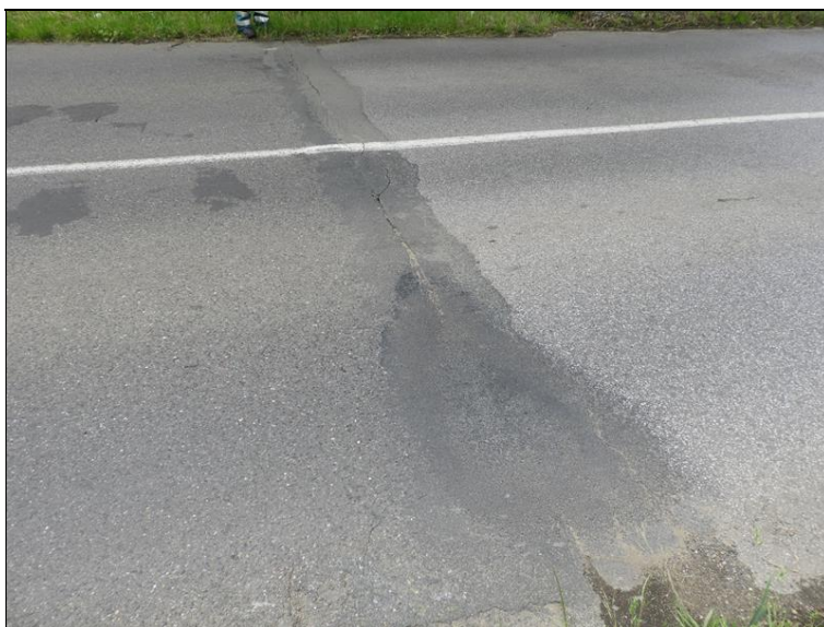
Příčná trhлина ve vozovce za mostem.
