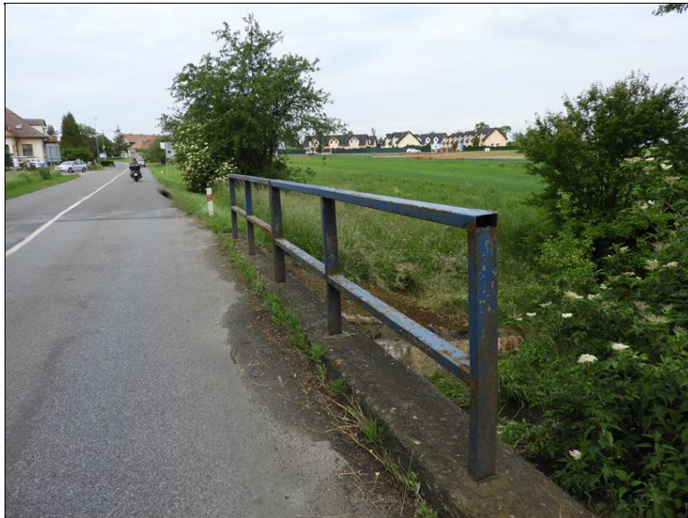
Stav levé římsy, degradace betonu, nánosy nečistot, vegetace, zkorodované zábradlí.
