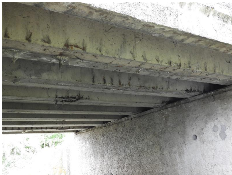
Nosná konstrukce. Trhliny v trámech, koroze výztuže, krápníky.
