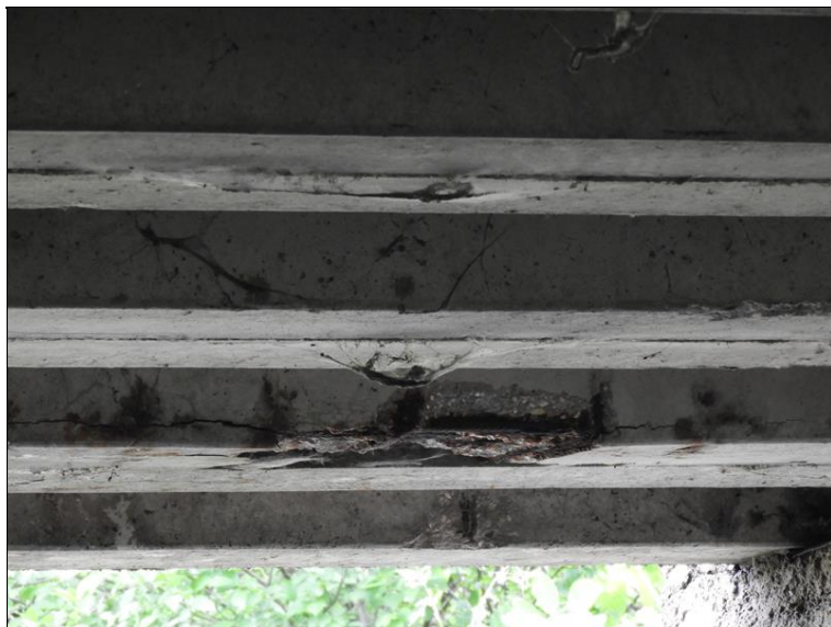
Odlamování betonu vlivem koroze výztuže.
