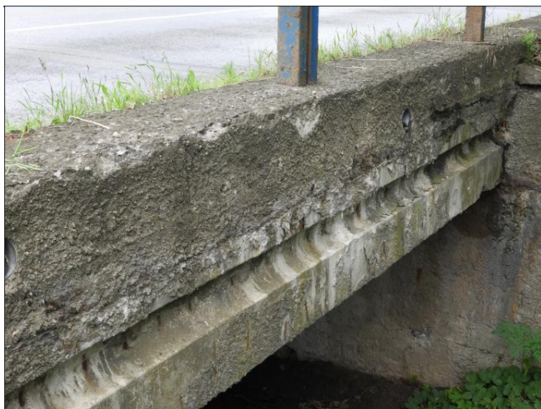
Koroze výztuže, degradace betonu, nosník zprava.
