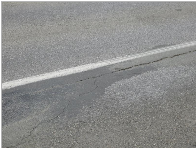
Podélná trhlina ve vozovce.
