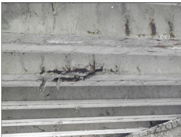
Odlamování betonu vlivem koroze výztuže.
