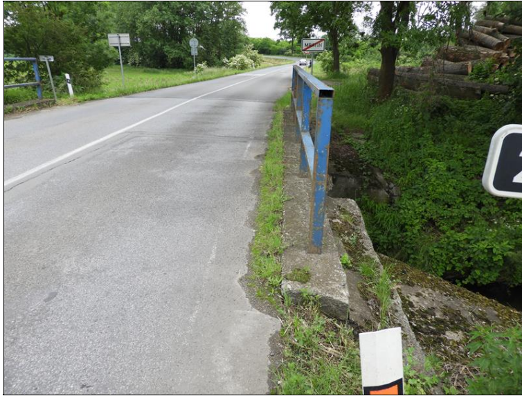
Stav pravé římsy, degradace betonu, nánosy nečistot, vegetace, zkorodované zábradlí.
