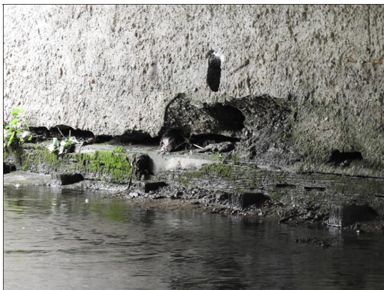
Degradace, vymílání betonu OP2.
